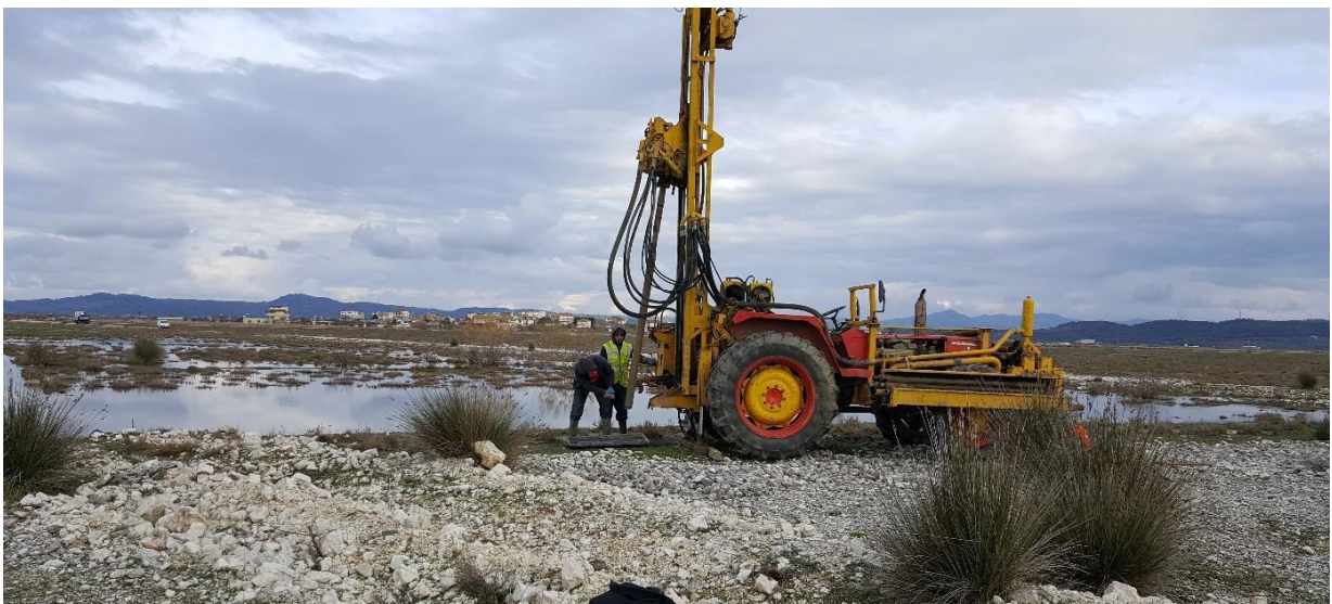
Figura 45: Foto gjate shpimit me sonde Bh. Nr. 1
